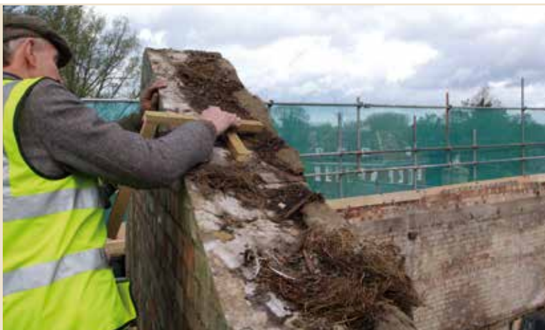
Photo 5 – Cette photo, prise durant des travaux en Angleterre, montre une série de nids qui se trouvaient sous des tuiles de rives / This photo, which was taken during work in England, shows a series of nests found under the verge tiles (© D. Newell)
