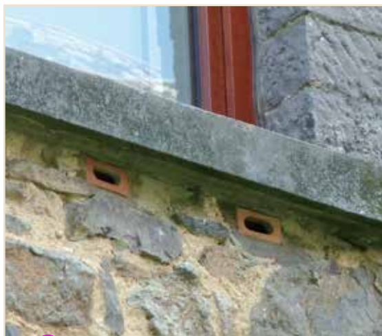
Photo 16 – Après avoir appris que la rénovation de cet ancien presbytère avait supprimé des cavités de martinets, le nouveau propriétaire a décidé de rétablir les trous colmatés. Conseillé par le GTM, il a retiré la nouvelle maçonnerie au burin puis réalisé un orifice esthétique et discret / Learning that the renovation of this former rectory had suppressed cavities used by Common Swift, the new owner decided to restore the holes which had been blocked. Following the advice of the Swifts Working Group, he removed the new masonry by chisel, replacing it by discrete and aesthetically pleasing entry holes (© P. Verstraeten)
